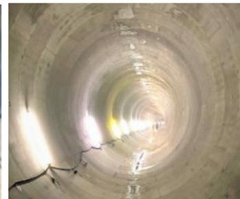
雨水管整備イメージ（中部2号幹線 内径5.00m）
